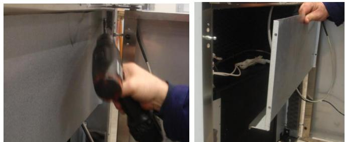
Удалить фиксирующие винты электрического щита.
