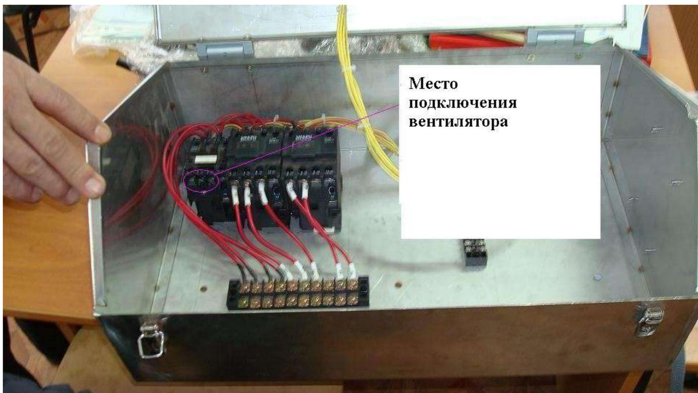
При подключении вентилятора обратите внимание на то, чтобы он вращался против часовой стрелки.
