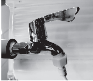
9. Su borusunun krana birləşdirin (kipləşdirici lentdən istifadə etməlidir).
