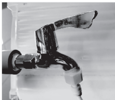
9. Присоедините водопроводную трубу к крану (используйте уплотнительную ленту).
