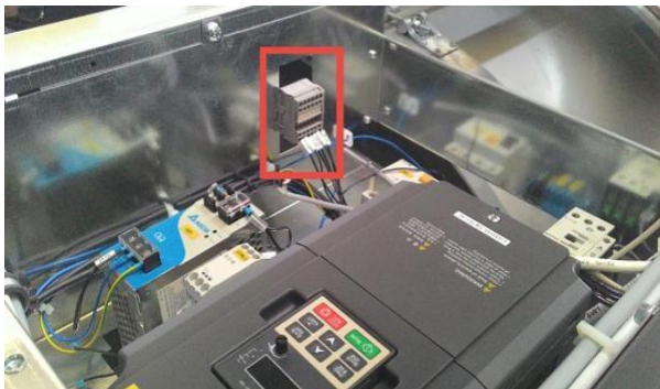
Фото 8 Расположение клемм подключения сигналов от мощного средства у WE20 / WE40
